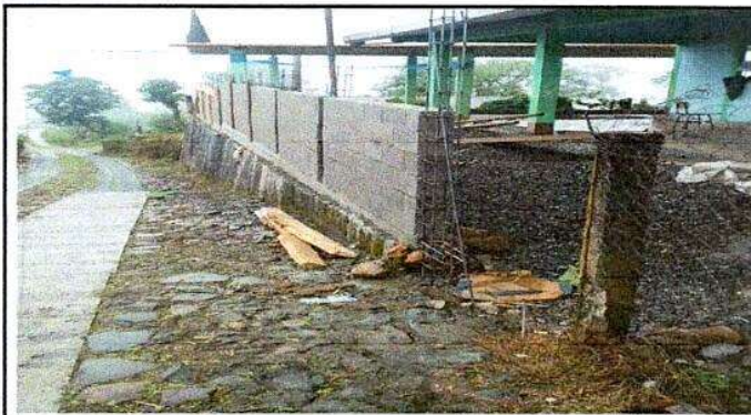
Foto 3: Reparación de muro perimetral de blok
