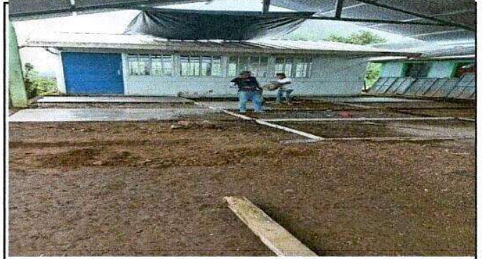
Foto 2: Sustitución de piso de torta de concreto
