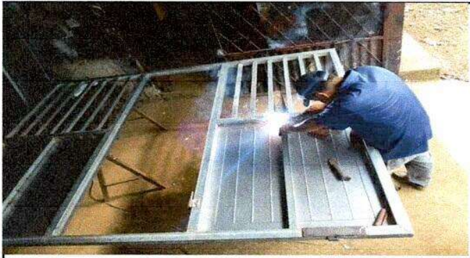
Foto 1: Sustitución de portón de metal
